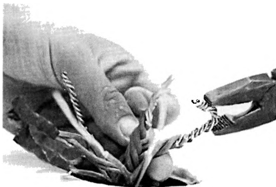
Рис. 2.91. Скрученные провода в месте установки разветвительной коробки
