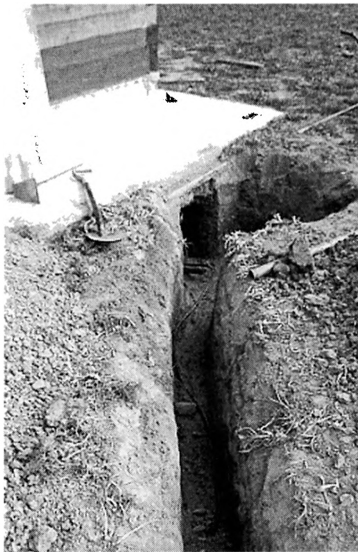
Рис. 2.108. Траншея для прокладки кабеля
